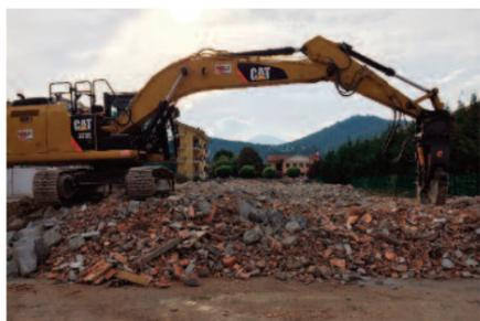
Dopo la rimozione delle coperture in amianto dei capannoni, sono stati demoliti i vecchi magazzini del consorzio agrario: durante i lavori il cantiere è stato monitorato per controllare la qualità dell'aria
