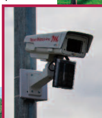
Si procede all'ampliamento degli impianti di videosorveglianza
