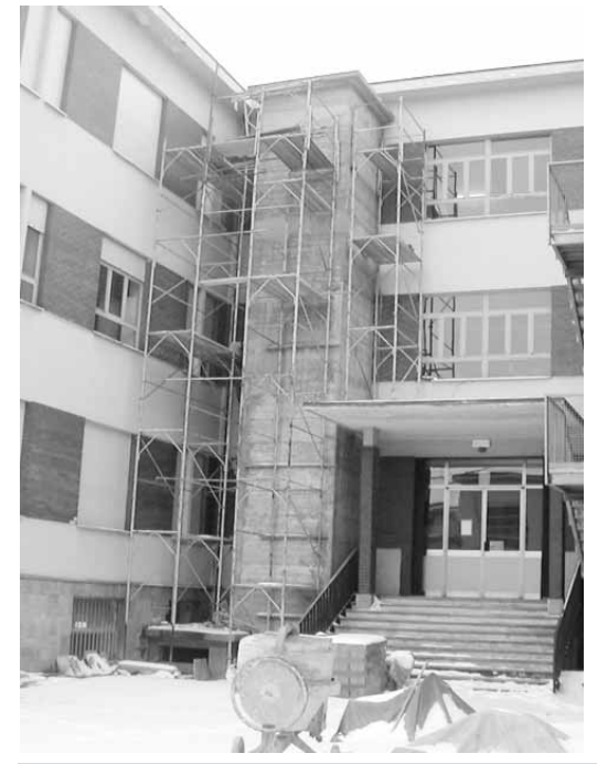
Scuole medie: cantiere per la realizzazione dell'ascensore
