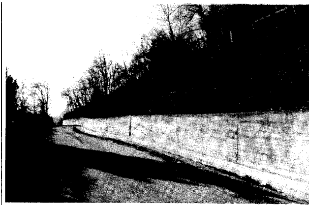
Lavori in Via Rossana per rimuovere la frana in collina
