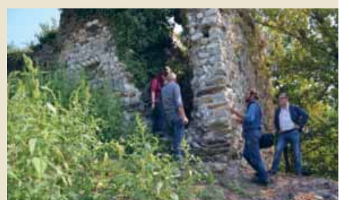
Sopralluogo del sindaco e dell'assessore al Castellaccio
