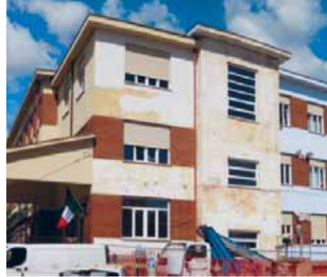
L'edificio delle scuole medie durante i lavori
