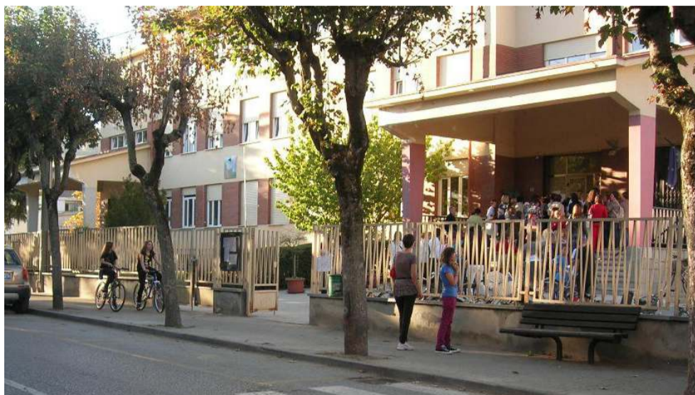
L'edificio delle scuole medie è stato oggetto di importanti lavori di adeguamento dal 2011 in poi
