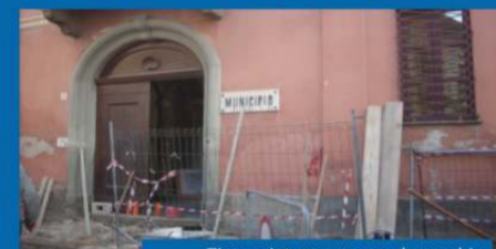
Tinteggiatura esterna alla vecchia delle scuole elementari e del municipio
