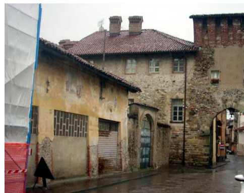
L'edificio in ristrutturazione
