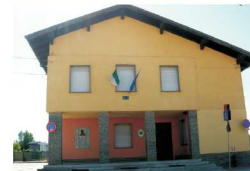
Le scuole elementari di frazione San Chiaffredo
