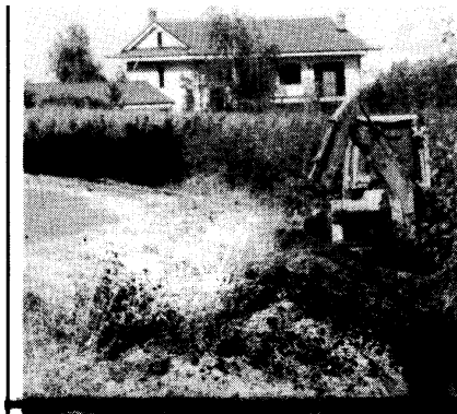
Lavori per la costruzione dell'acquedotto di San Martino
