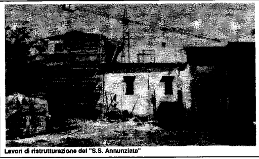
Lavori di ristrutturazione del "S.S. Annunziata"
