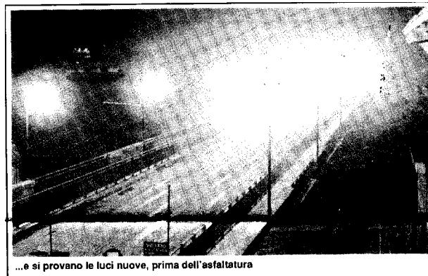
...e si provano le luci nuove, prima dell'asfaltatura
