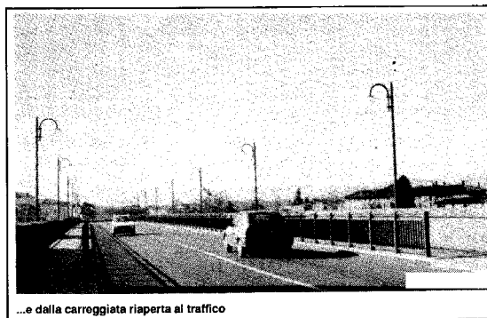
...e dalla carreggiata riaperta al traffico
