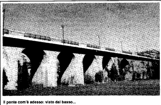
Il ponte com'è adesso: visto dal basso...
